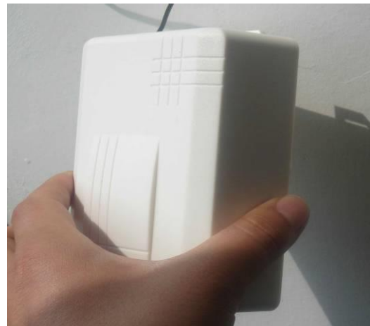
Afmontere elektronikboksen fra væggen
